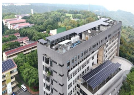
太陽能光電設置資教大樓
